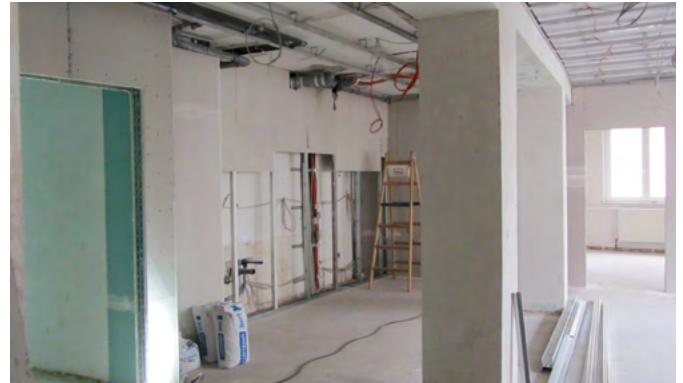
Baustelle der neuen Notschlafstelle Fotos: Hängematte e.V.
